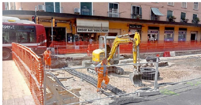
Operai al lavoro sul cantiere del tram in Bolognina
